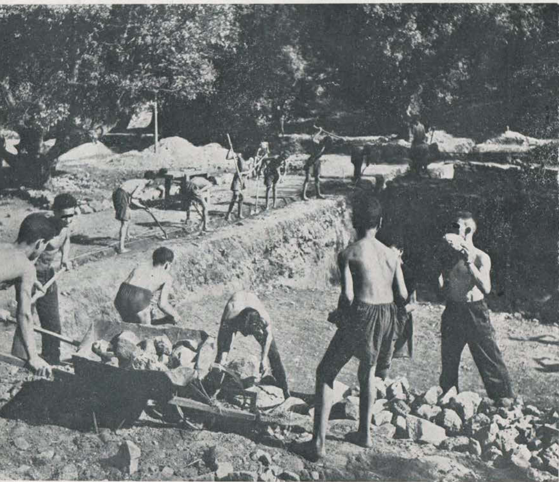
CONSTRUCTION D'UNE PISCINE DANS UN CAMP DU MOYEN-ATLAS.
